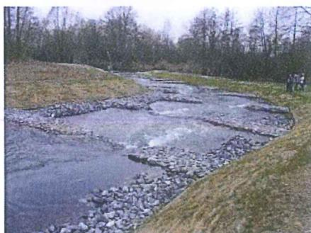
Ainsi, en accord avec les services de l'état, SHEMA a décidé de réaliser une « rivière artificielle de contournement » qui permet la circulation des poissons sans être entravée par la présence du barrage.
