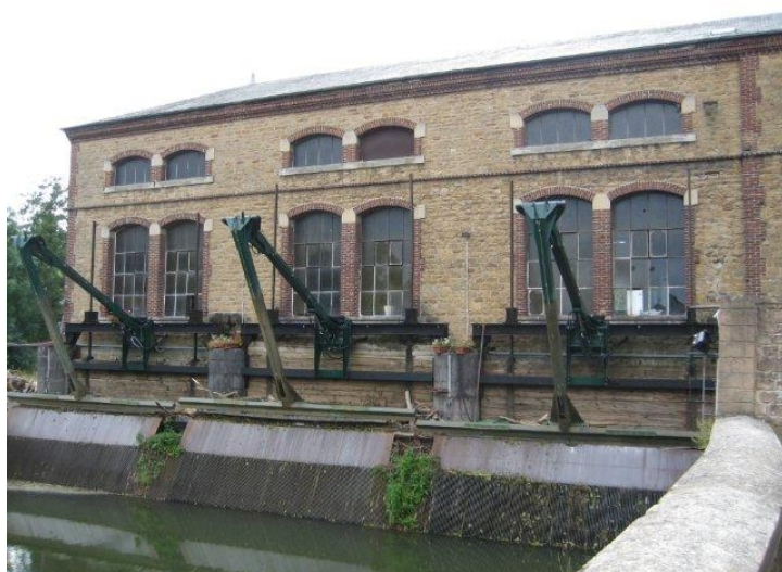
Exterieur amont de la centrale
