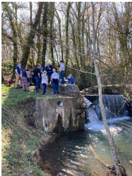
Visite du site de micro-hydroélectricité
